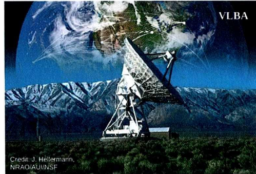
Very Long Baseline Array (VLBA) – радиointерферометр Национальной радиоастрономической обсерватории (NRAO) США, состоящий из 10 антенн.
